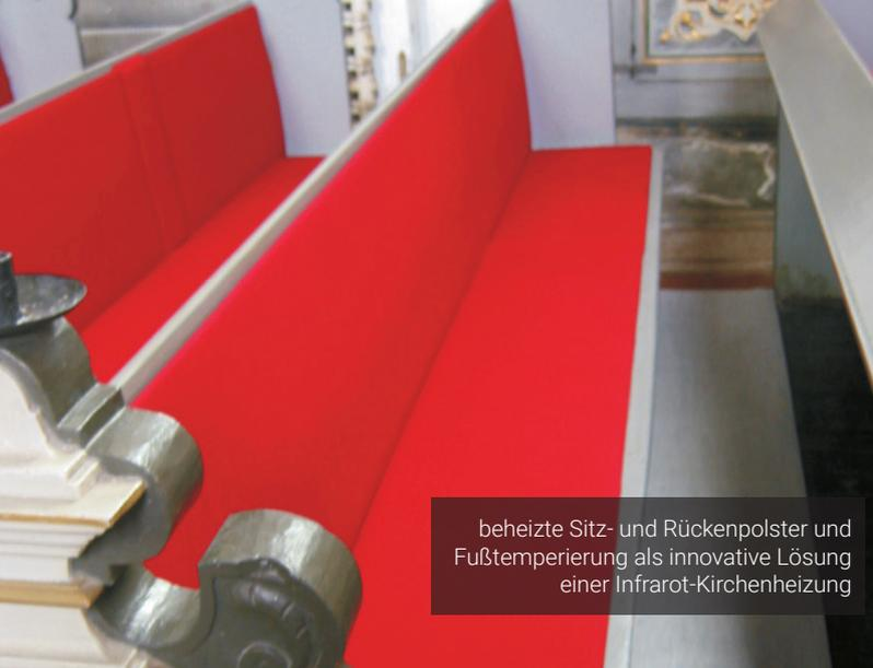
beheizte Sitz- und Rückenpolster und Fußtemperierung als innovative Lösung einer Infrarot-Kirchenheizung
