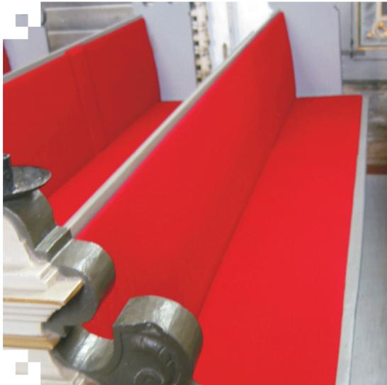
beheizte Sitz- und Rückenpolster und Fußtemperierung als innovative Lösung einer Infrarot-Kirchenheizung
