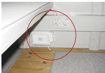
Anschluß an Sicherheitstransformator einer Fußheizung mit Teppichbodenbelag
